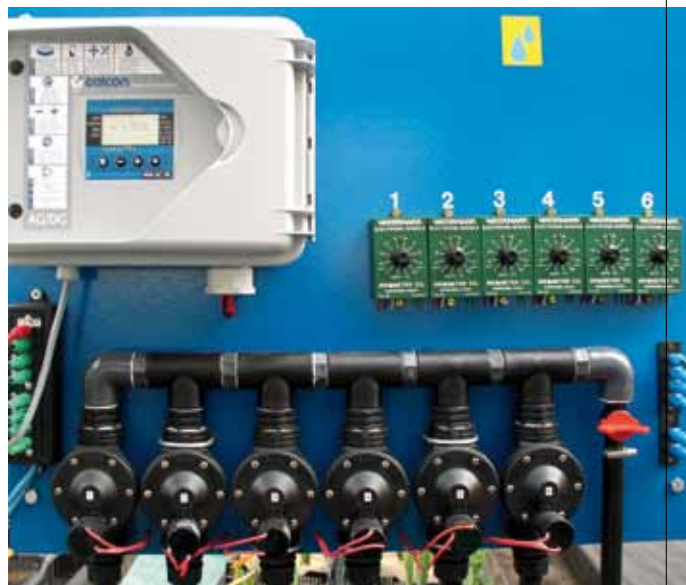
Fot. 3. System sterowania nawadnianiem wykorzystujący sensory granular matrix
