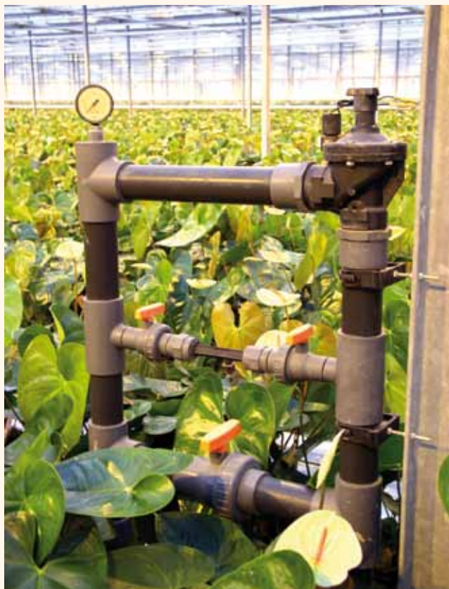
Fot. 3. Inżektor zamontowany indywidualnie na sekcji nawodnieniowej
