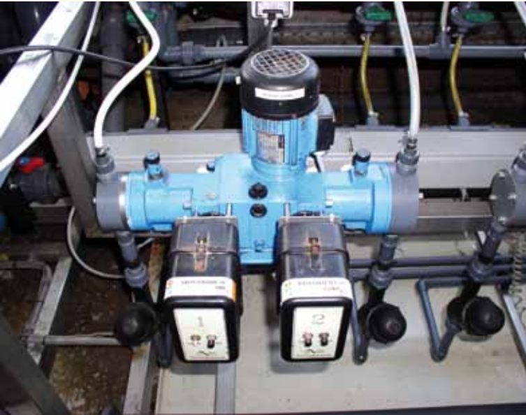
Fot. 6. Przykład instalacji z elektryczną pompą dozującą
