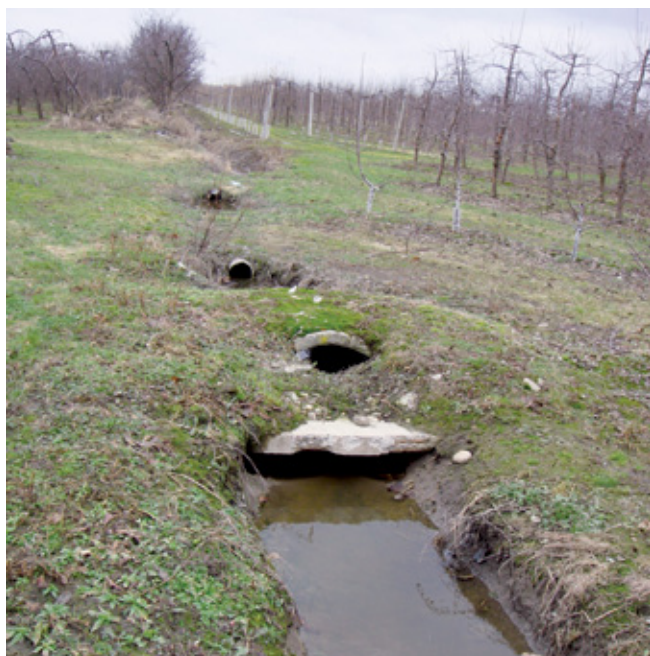
Niewłaściwe utrzymanie przepustów na rowie oraz rowów melioracyjnych
