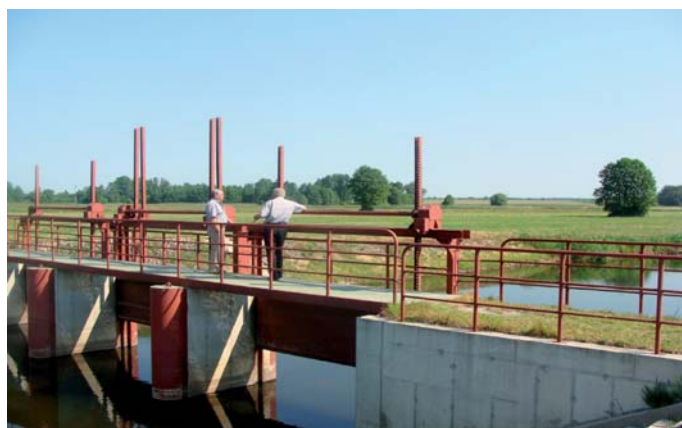
Fot. 2. Jaz Sycyna-Puchacze na rzece Krzna o świetle 3 x 4,0 m, wys. piętrzenia h=2,0 m i h=1,2 m pojemności korytowej 70,5 tys. m 3 , odbudowany w 2003 r. w systemie Kanału Wieprz-Krzna
