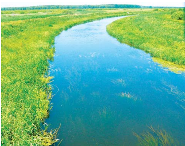
Fot. 1. Odcinek nawadniający Kanału Wieprz-Krzna w km 15+375 w rejonie drogi o kierunku Lublin - Chełm
