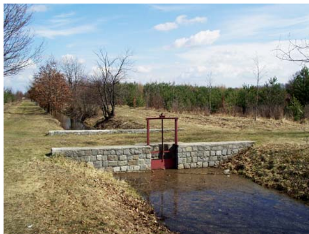
Przepust z piętrzeniem hamujący w okresie wiosennym odpływ z potoku Ługowinka (fot. T. Kowalczyk)
